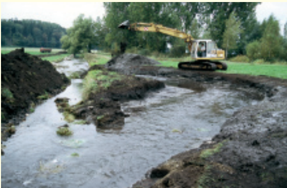
Anlage eines neuen, naturnahen Gewässerbetts.
