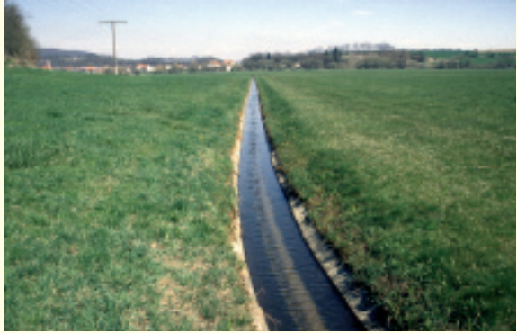
In Oberschwaben noch häufig anzutreffen: ausgebauter Bachlauf mit Sohlschalen.
