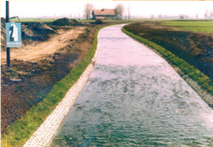
Vor der Renaturierung: Kanalisierte Schwarzach mit durch Rasengittersteinen befestigten Ufern.
