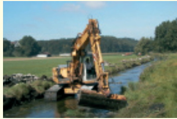
Entfernen der Rasengittersteine.
